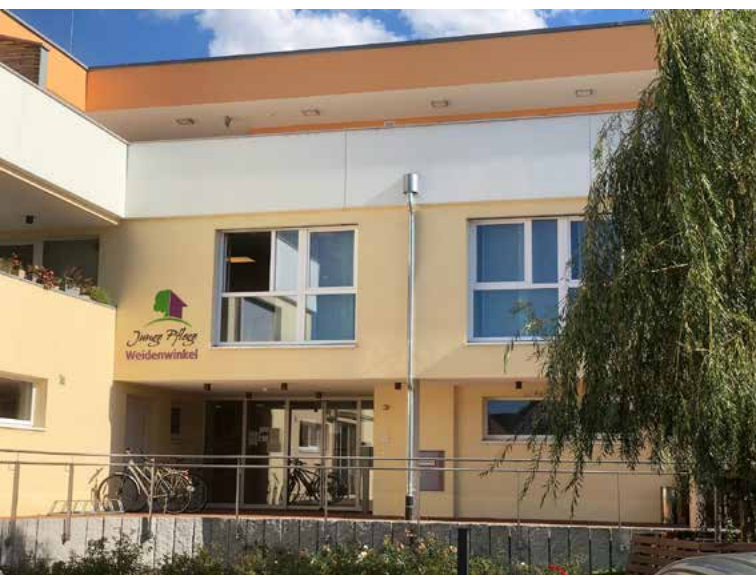
Blick auf das Gebäude der Wohngemeinschaft
