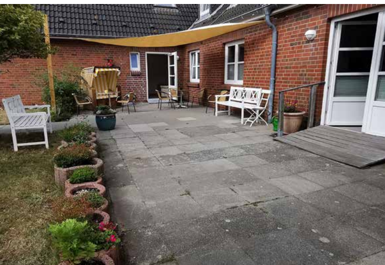
Nicht barrierefreie Außenanlage – Umbaumaßnahmen stehen an
