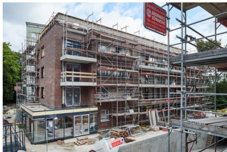
Blick auf den Neubau Spannskamp
